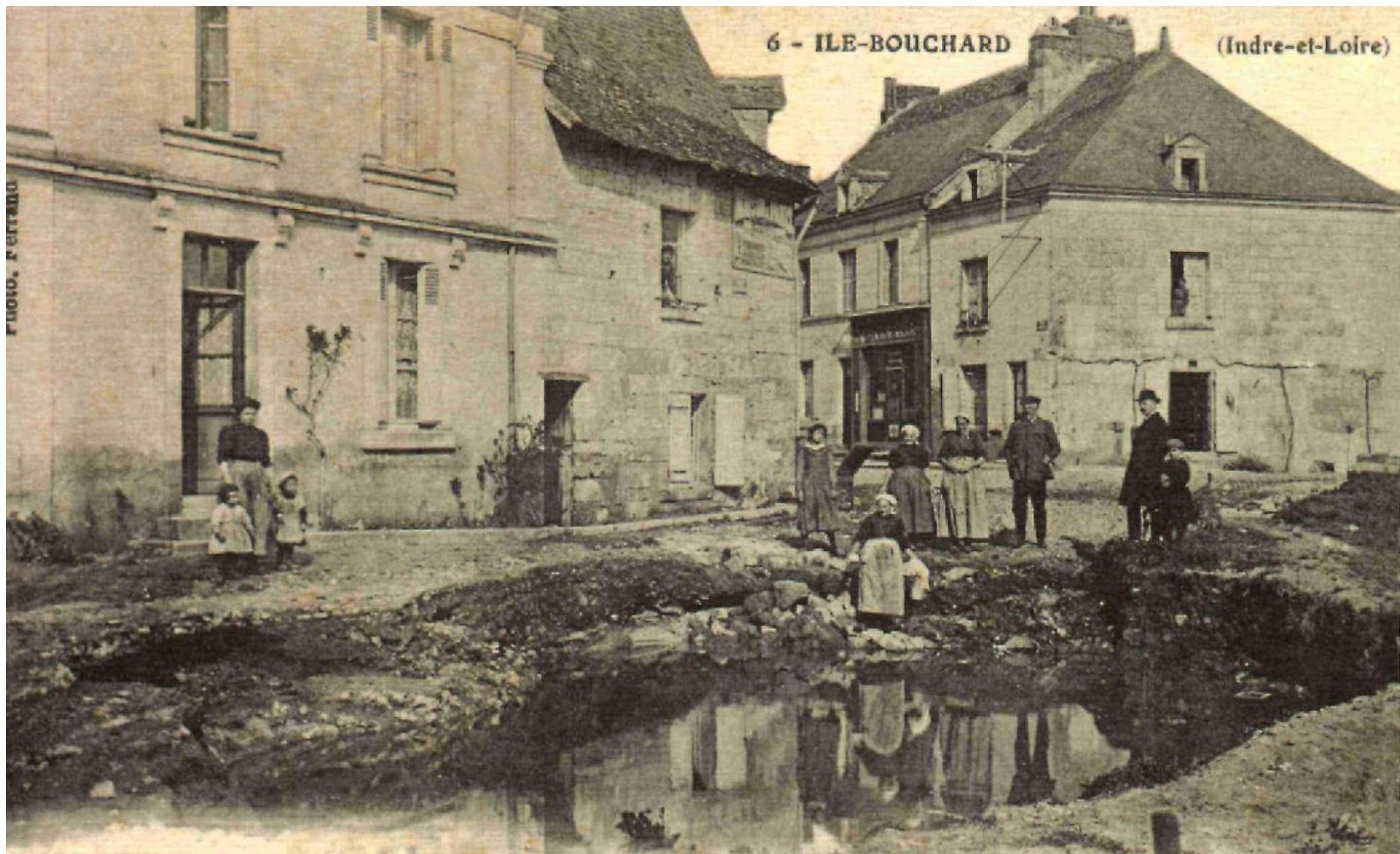
Crue de la Vienne (30 Mars-1<sup>er</sup> Avril 1913) - Excavation de 11<sup>m</sup> 50 de long, 8<sup>m</sup> de large et 2 <sup>m</sup> 50 de profondeur, creusée près l'extrémité du pont de St-Gilles sur la Vienne à l'entrée de la rue de la Liberté
